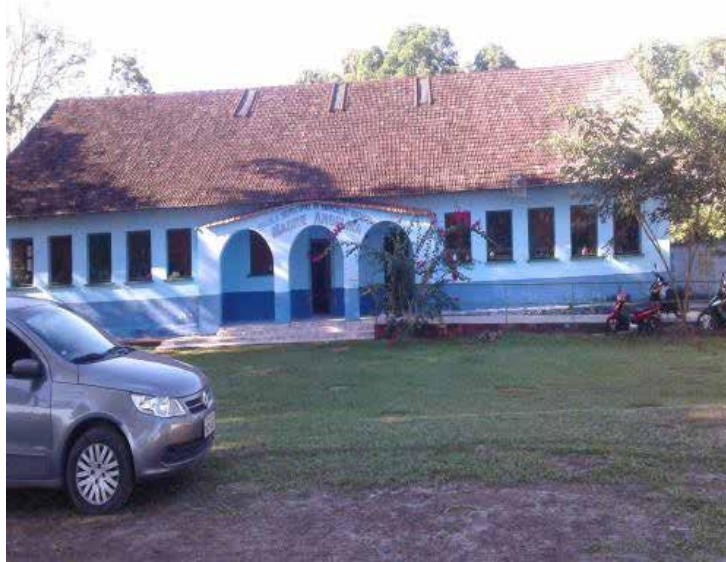
Figura 2 – Prédio da escola
